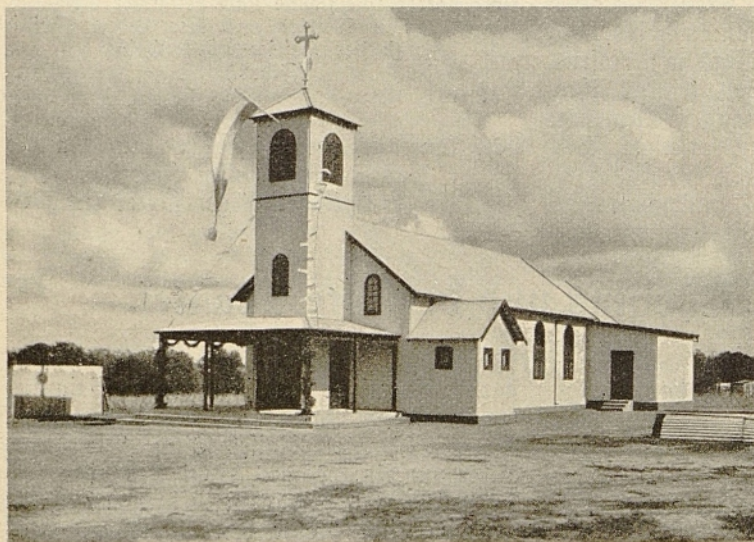
Die neue Eingeborenenkirche in Witbank.
