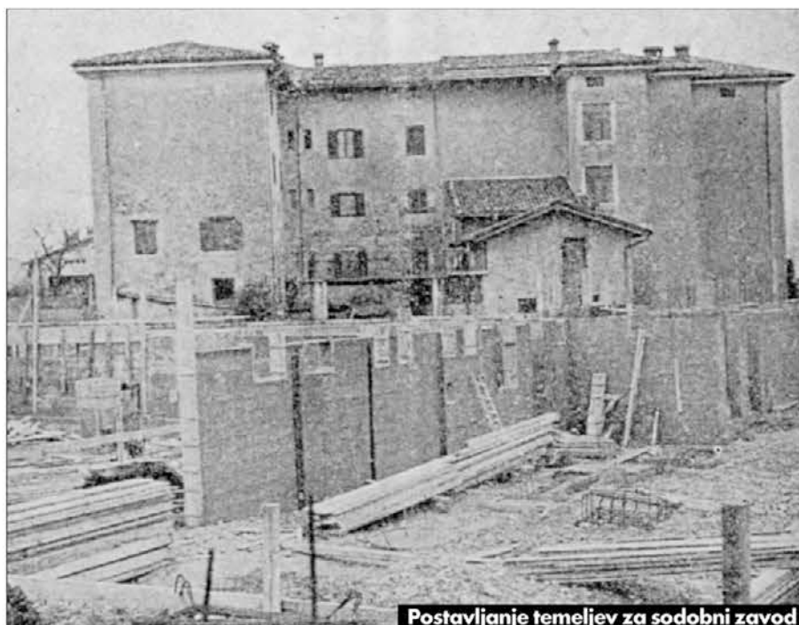
Postavljanje temeljev za sodobni zavod
