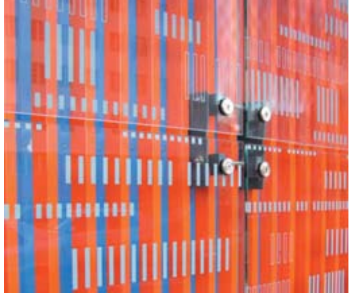
Slika 4: Prozorno steklo kot zaščita dekorativne podlage. (Foto: Viki Žigon) Translucent glass cladding as protection for decorative cladding.
