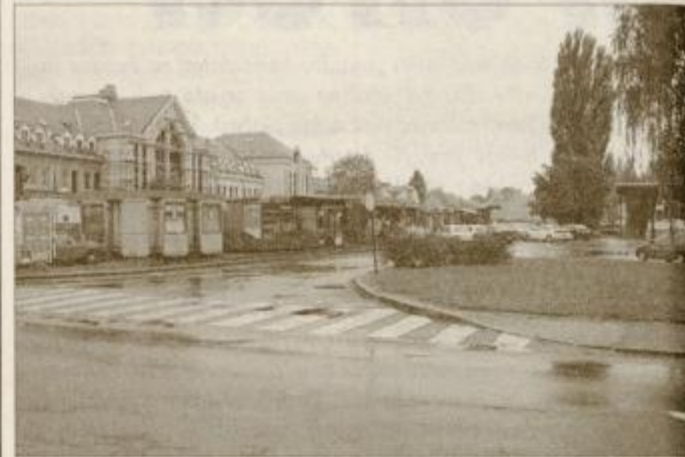
Kioske na avtobusni postaji bo zamenjal paviljonski objekt
