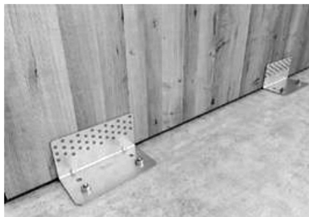
Slika 4: Sidranje X-lam stenskih plošč s kotniki za prevzem strižnih obremenitev na spoju beton/les 9
