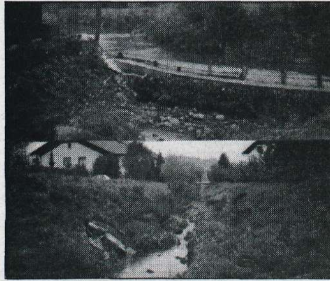
Z deskami povišan prag na Pšati (zgoraj). Šele poseka je odkrila »zamašeno« strugo razbremenilnika (spodaj).
