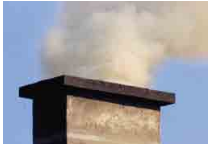
Temnejši ali temen gost dim na vrhu dimnika je pokazatelj zelo slabega zgorevanja (Vir: www.richtigheizen.at )
