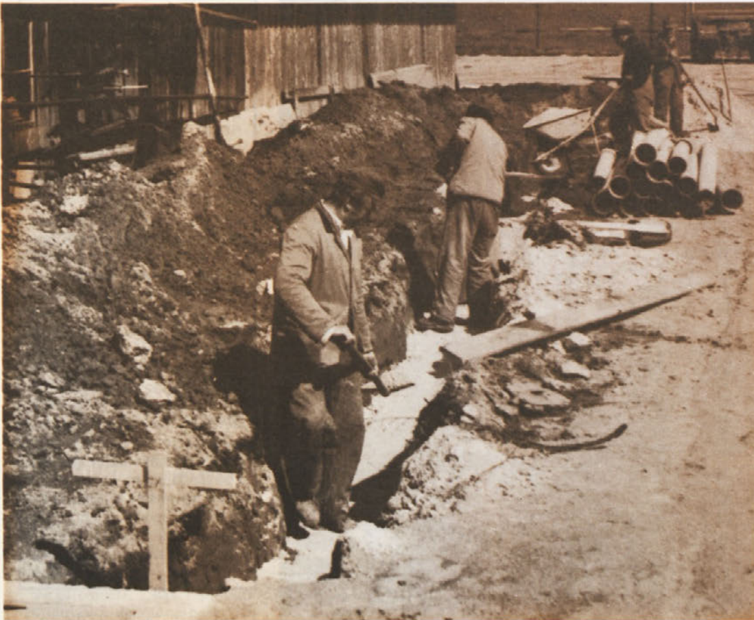
Naši gradbinci pripravljajo teren za polaganje cevi, ki bodo služile odvodu meteorske vode
