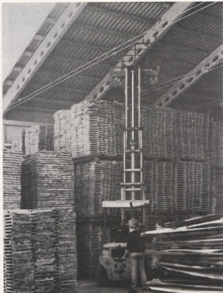
Viličar posebne vrste, ki zmore postaviti palete celo pod sam strop
