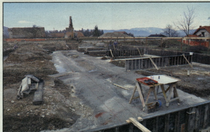
Po temeljih je že mogoče videti približno tlorisno podobo šole, vrtca in telovadnice
