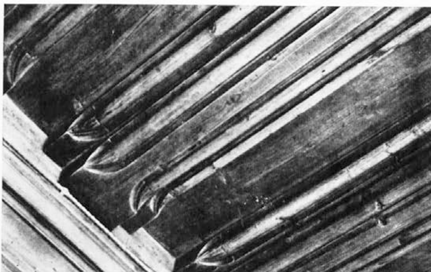
Sl. 46. Radovljica, Sivčeva hiša na Linhartovem trgu; lesen strop v prvem nadstropju iz 16. stol. Radovljica, maison de Sivce, Linhartov trg; plafond de bois au 1er étage, 16e siècle
