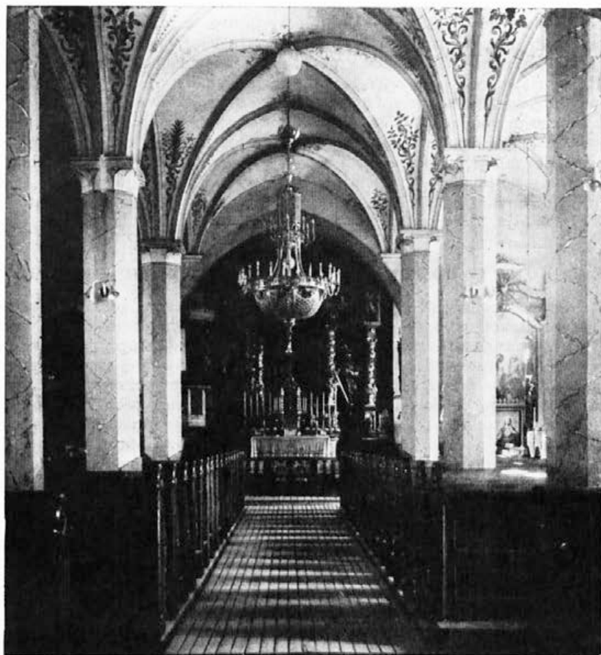
Sl. 2. Leskovec pri Krškem; župna cerkev; druga četrtina 16. stol. Leskovec près de Krško; église paroissiale; second quart du 16 e siècle
