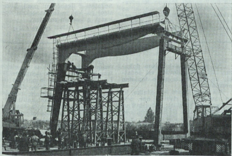
Montaža dvigala na ploščadi za pločevinarno (Foto Zlebnik)
