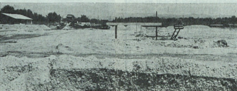
Pripravljalna dela za novo halo TVN (Foto Žlebnič)
