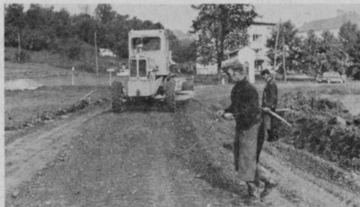
V Leskovcu gradijo asfaltno cesto
