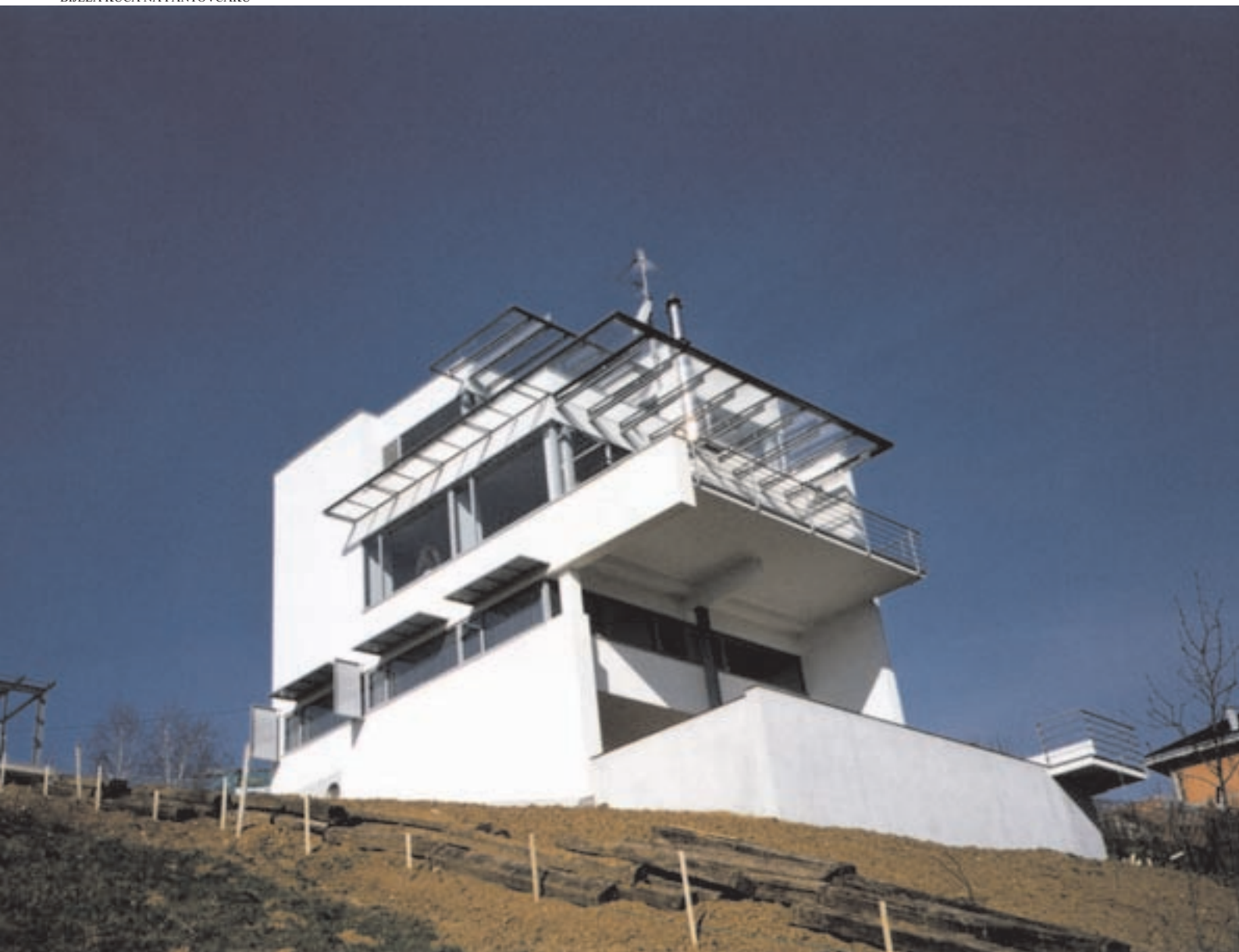
Slika 2: Pogled na objekt iz vrta. A view of the building from the garden.
