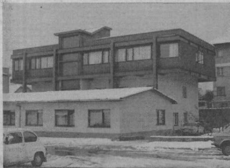
Poslovna stavba GP Bežigrad se ponša z nenavadno »kapo«. Sami so si zamislili način nadzideve, saj sicer temelji ne bi zdržali novega nadstropja, pa so si pomagali z oporniki – zdaj lahko stavbo dvignejo še za eno ali dve nadstropji.
