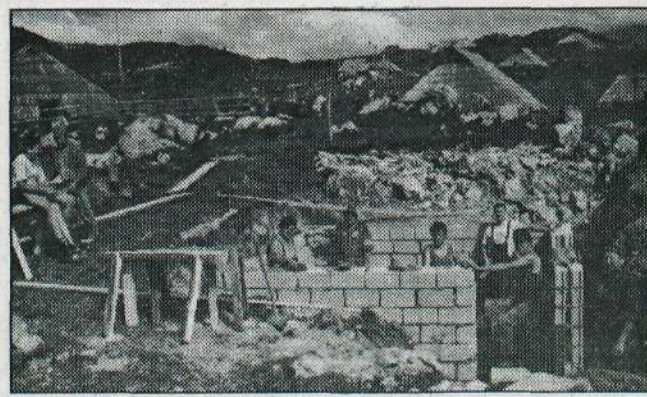
Temelji za veterinarsko postajo so zidani, tako da bo kočja imela tudi primerno klet.
