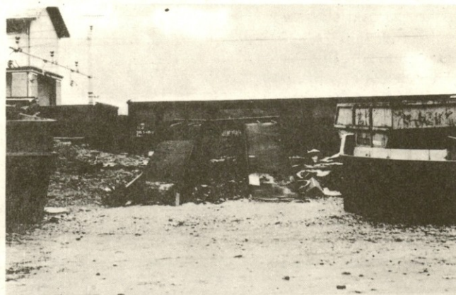
Nakladalna rampa ob industrijskem tiru
