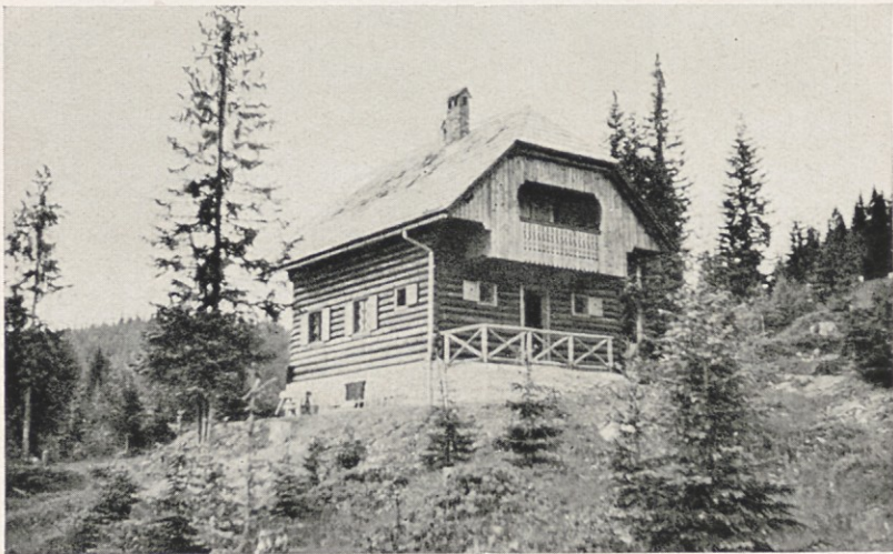
Sliki 159. in 160. Planinska koča na Pokljuki. (Projektiral Jože Karlovšek. Zgradil tesarski mojster Franc Šparovec.)
