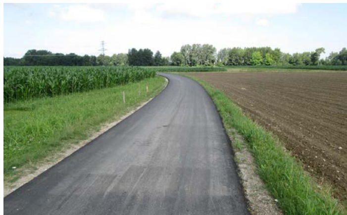
Preplastitev ceste Šturmovci–Pobrežje
