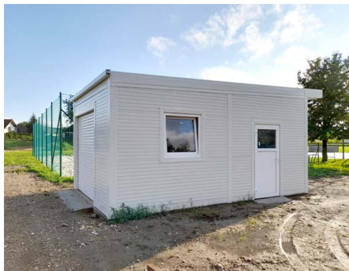
Nov montažni skladiščni objekt
