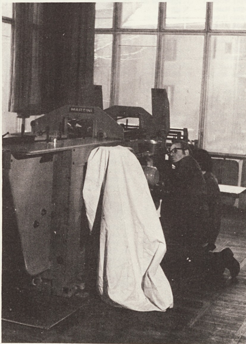
Stroj za avtomatsko broširanje knjig „Econobinder“ tovarne „Martini“
