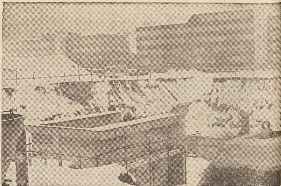
Začetek gradnje skupne poslovne zgradbe SOZD Emone na Smartinski cesti v Ljubljani, ki je začela rasti iz zemlje.
