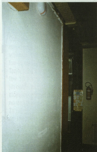
Slika 7: Nagnjena polnilna stena iz siporeksa
