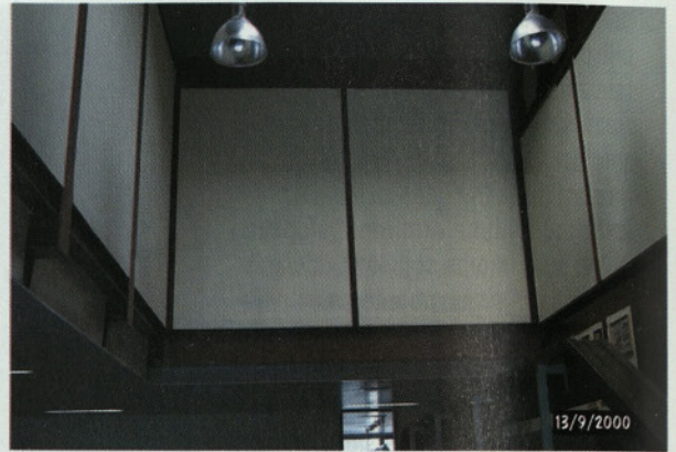
Slika 12: Vertikalna jeklena vez na večji steni ob stopnišču
