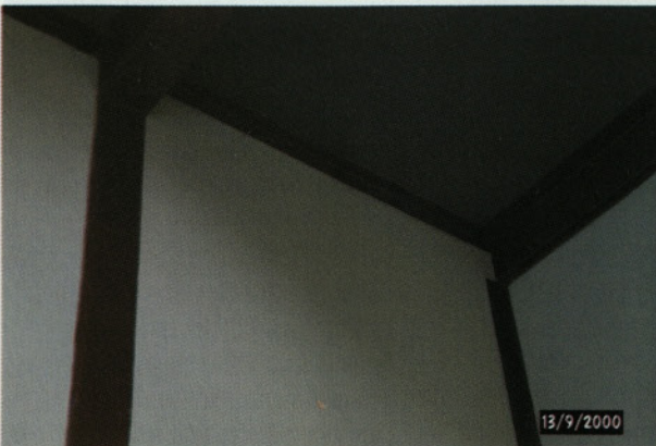
Slika 11: Vertikalna jeklena vez in stranska pritrditev polnilnih siporeksnih sten na jeklene stebre
