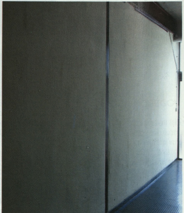
Slika 14: Ojačitev dolge stene ob hodniku
