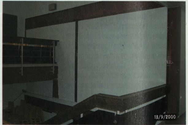
Slika 13: Vertikalna jeklena vez na večji steni ob stopnišču
