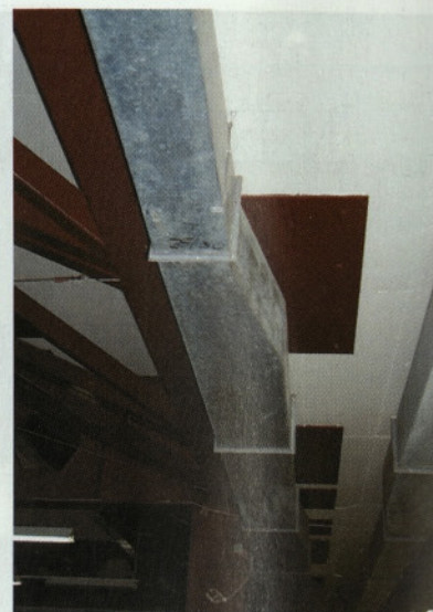
Slika 20: Pritrditev jeklenega paličja na spodnjo ploščo objekta
