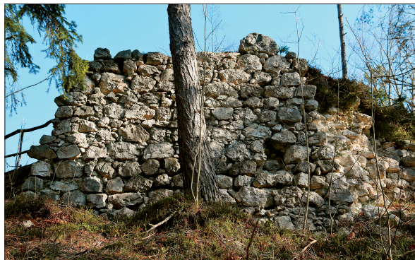
Struktura visokosrednjeveške kamnite zidave na zunanji strani južnega konca obodnega obzidja spodnjega dela gradu (foto: Igor Sapač, 2020).
