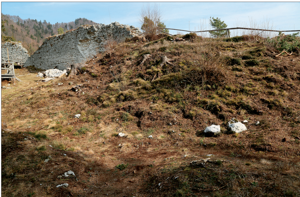
Pogled na ruševinsko grobljo oziroma kopo z lokacijo nekdanjega visokega grajskega stolpa z jugozahodne strani (foto: Igor Sapač, 2020).
