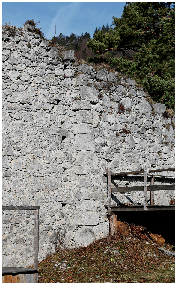
Pogled na dvoriščno stran severnega dela zahodne stranice obodnega obzidja zgornjega dela gradu z vidnim stopničastim zamikom zidnega plašča (foto: Igor Sapač, 2020).
