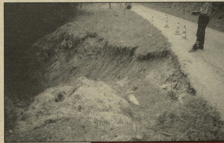
Usad na lokalni cesti
