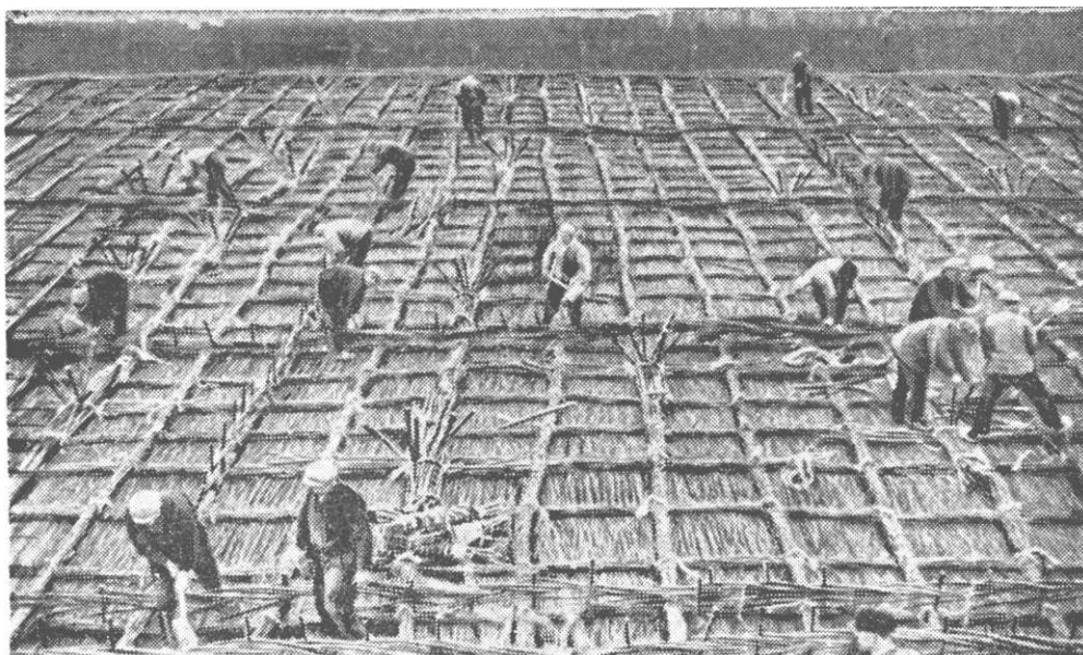
TEMELJ ZUIDERSKEGA JEZU. Zaradi nestalnosti morskih tal so najprvo pogrezali na dno velike butare vrbičja, obtežene s skalami bazalta
