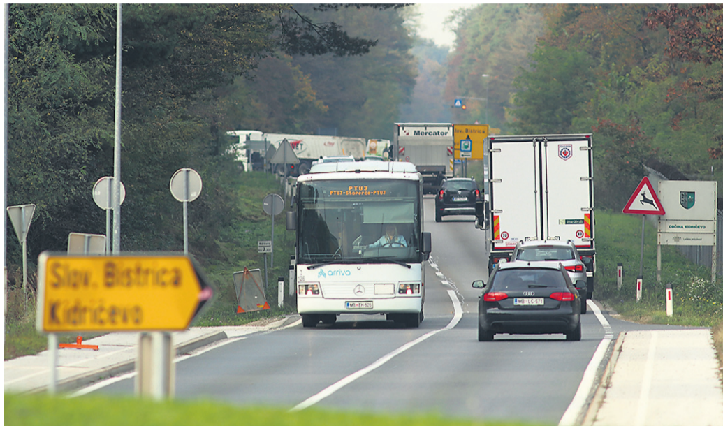
Razpis za izvajalca del na 15-milijonskem projektu gradnje kidričevske obvoznice bo DRSI objavila predvidoma še ta mesec.
