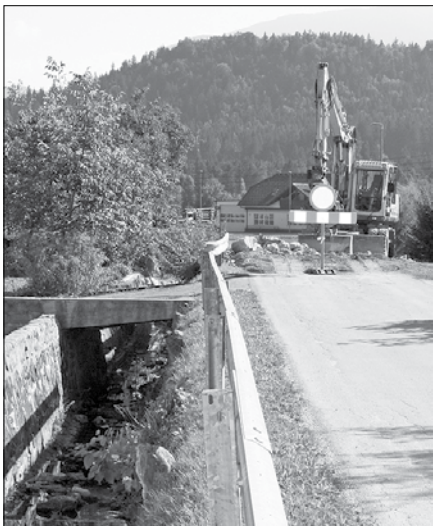
Prenova Zajčevega mostu v Okonini (Foto: Marija Lebar)
