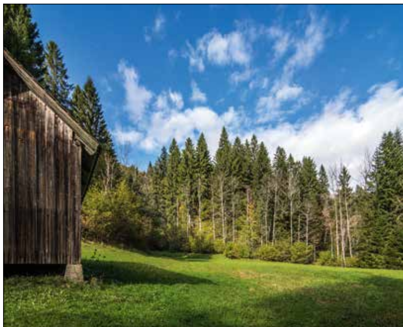
Pogled na danes zaraščeno rudišče pri Knapah. Na grebenu je mogoče najti še sledilne rove in odval rude. Foto: Matija Križnar
