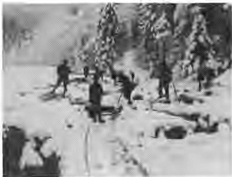
Skladišče lesa v Globaši 1937. Vidni so tiri, po katerih so spravljali les do hudourniške pregrade (puč)
