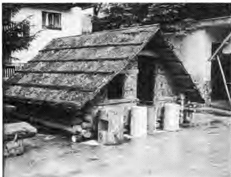
Olcerska bajta za 4 delavce, zgrajena v Lučah za turistično priveditev. Je veren posnetek prave bajte, vendar so uporabljeni žebliji, ki jih pri gradnji nekdanjih olcerskih bajt niso uporabljali
