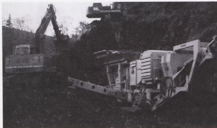
Gradnja ceste Arnfels - Kapla
