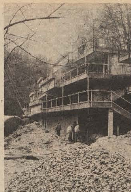
Gradbena dela pri ureditvi kopalnega bazena s slačilnicami in drugimi potrebnimi objekti v Šmarjetkih Toplicah se bližajo koncu. Čeprav je okrog gradbišča še precej razmetano, bodo do konca maja vsa dela končana. Na sliki: gradnja slačilnic, bifeja... (Foto: S. D.)
