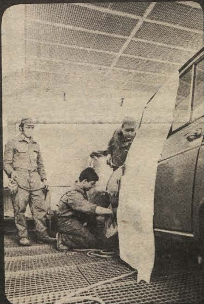
Najnovejša pridobitev PIONIRJEVEGA avtoservisa je moderna lakirnica s sušilno komoro s temperaturo do 100°C
