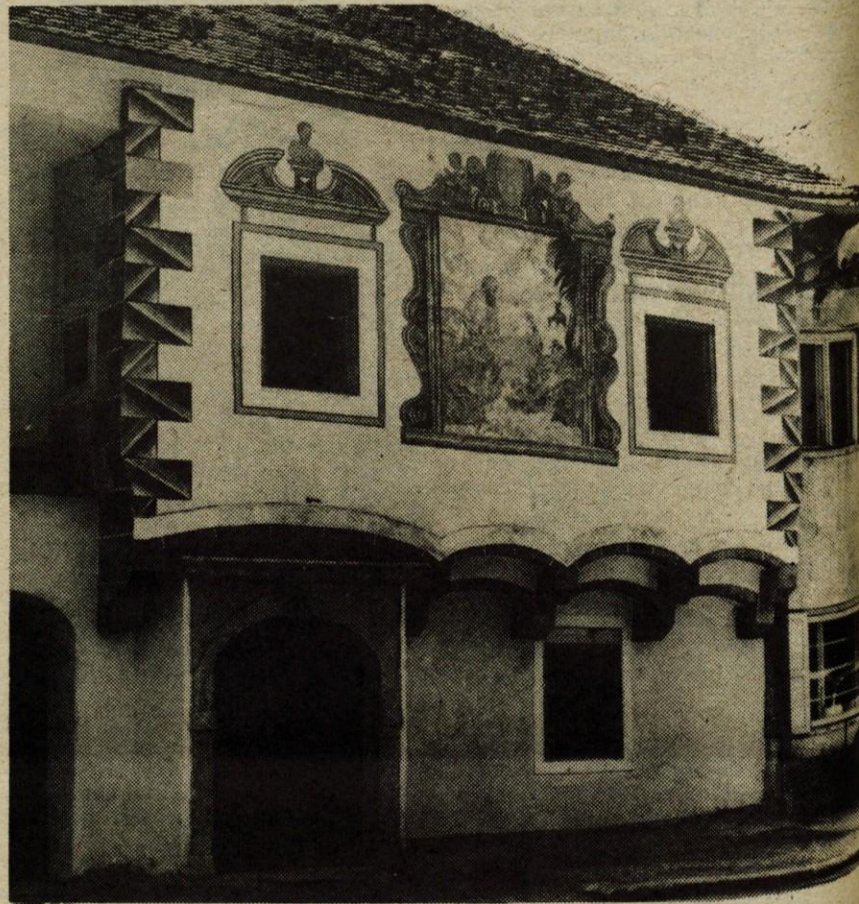
Ureditev Šivčeve hiše je le del širokega programa ohranitve in obnove kulturnih znamenitosti starega dela Radovljice.
