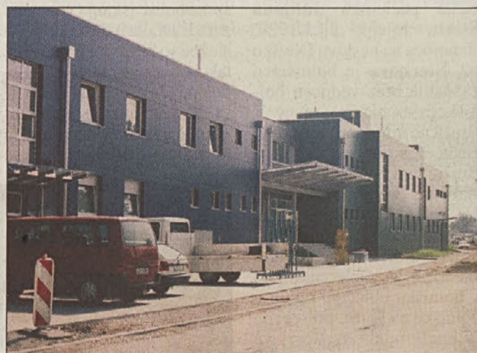
Skraini desni rob novega sodobnega poslopja v Dobovi že naseljujejo slovenski policisti, trenutno pa potekajo še zaključna dela na cesti in pločniku.
