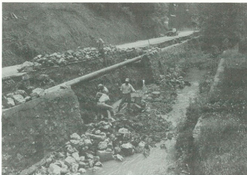
Gradnja podpornega zidu pri dvorani "Svobode".
