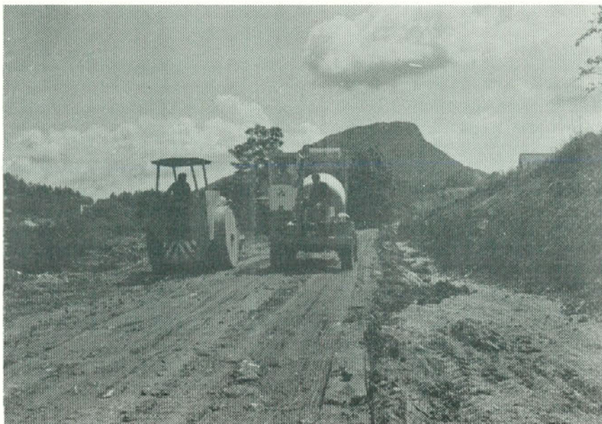
Gradnja nove ceste v Libojah.
