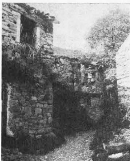
Tu vidimo razpadajoče hiše v Oborči, ki leži precej visoko v hribu
