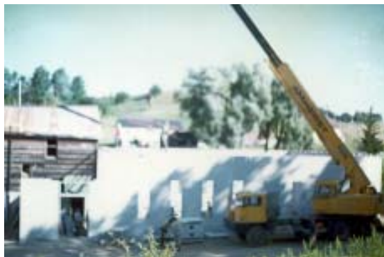
Žerjav polaga nosilce za strop in streho
