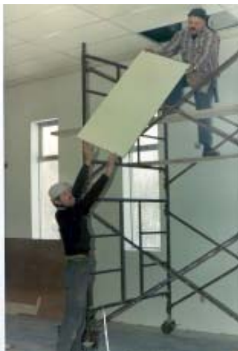
Vinko Jereb in Kludi Humer polagata zadnjo stropno ploščo
