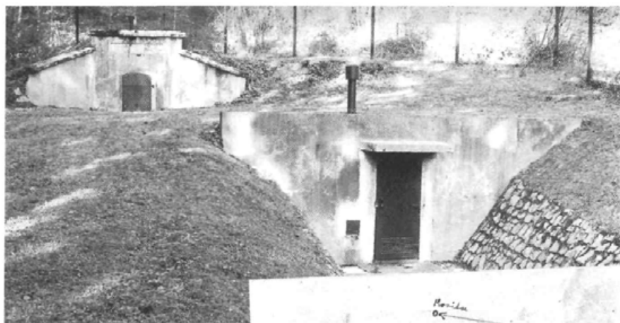
43. Vodno zajetje v Stajah, zgrajeno leta 1904.
