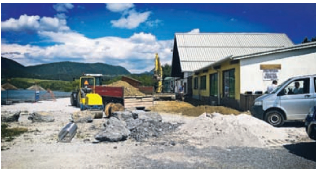
Letos bo plaža dobila dodatno gostinsko ponudbo. Plato, na katerem bodo postavili kioske za prodajo prigrizkov in sladoleda na kepice, že stoji, gradbena dela težejo tudi ob čolnarne, ki bo dobila novo vodovodno in električno napeljavo.
