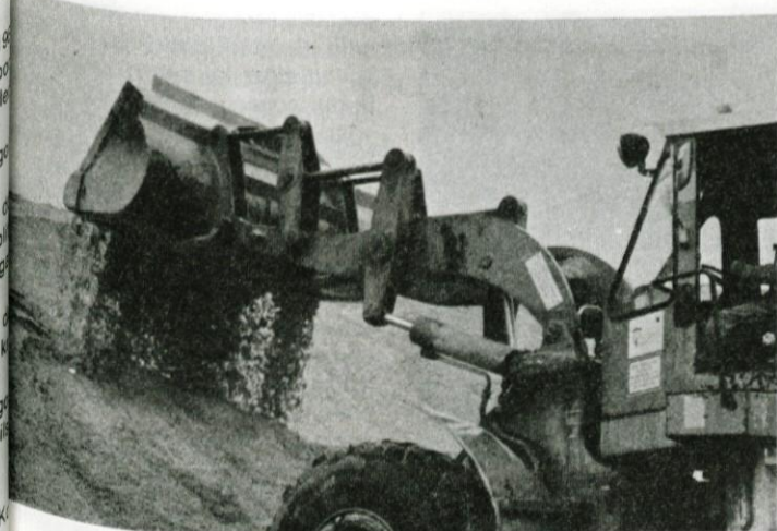
betonskega peska je v Smolevcu dovolj (Foto S. Hodnik)
