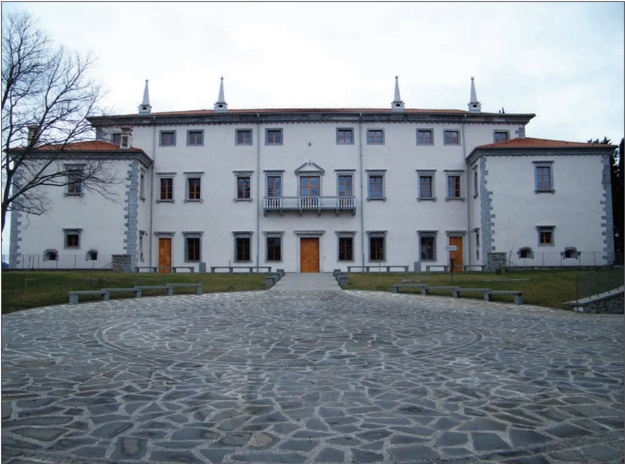
Figure 8: North facade of the Vipolže Castle after its restoration, January 2015 (photo: Marta Lombardi) Slika 8: Severna fasada Gradu Vipolže po restavratorskem posegu, januarja 2015 (foto: Marta Lombardi) Figura 8: Facciata nord del Castello di Vipulzano dopo il restauro, gennaio 2015 (foto: Marta Lombardi)
