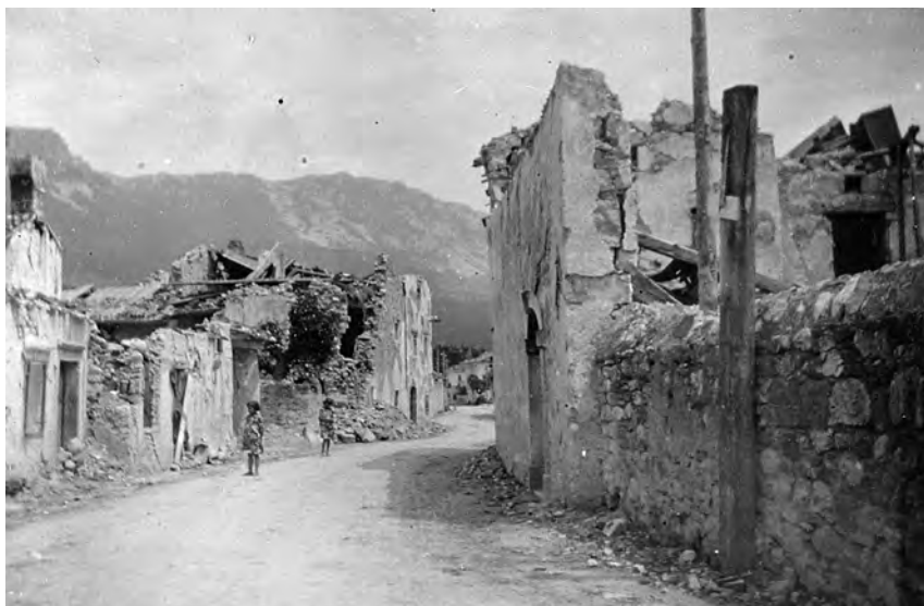
FOTO 36: AJDOVŠČINA – PORUŠEN ZASELEK PUTRIHI PO EKSPLOZIJI SKLADIŠČA MUNICIJE. MED ŽRTVAMI JE BILO TUDI OKROG 30 RUSKIH VOJNIH UJETNIKOV, KI SO POKOPANI NA AJDOVSKEM POKOPALIŠČU. VIR: USTANOVA “FUNDACIJA PITI MIRU V POSOČJU”.
