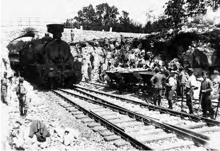
FOTO 24: GRADNJA ŽELEZNIŠKE INFRASTRUKTURE NA OBČINAH. TRASA SEŽANA- REPERTABOR. VIR: ARHIV HERMANN. FOTO LEMMEL. HRANI IGOR DOLENC.
