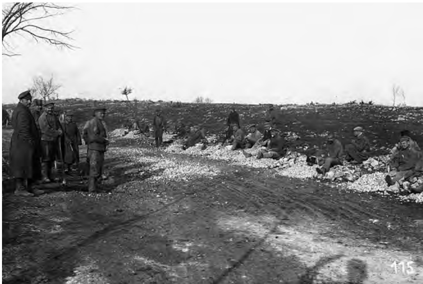
FOTO 28: GRADBENA DELA NA KRASU. VIR: ZASEBNI ARHIV SIMONA KOVAČIČA.
