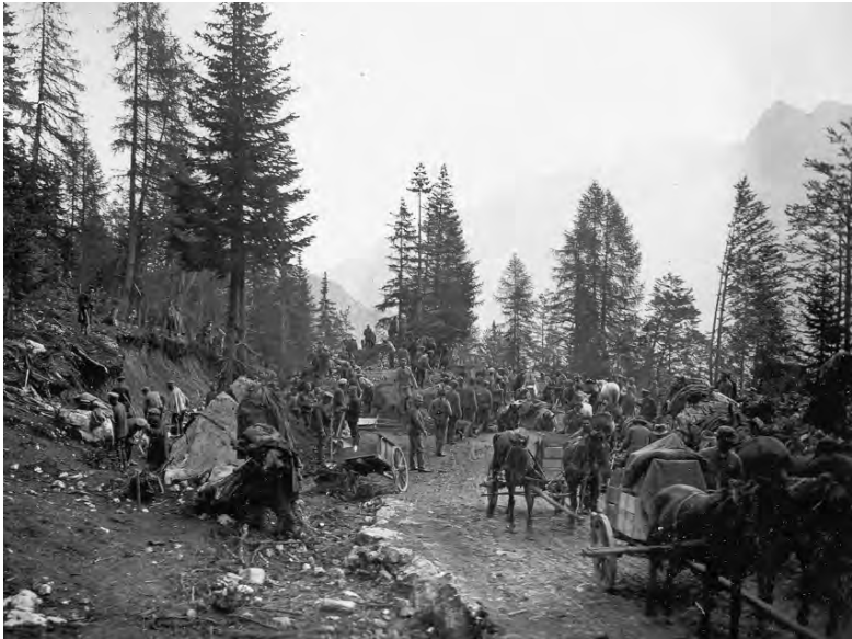
FOTO 15: GRADNJA CESTE ČEZ PRELAZ VRŠIČ. VIR: ZASEBNI ARHIV W. ETTERICHA, NEMČIJA. HRANI USTANOVA "FUNDACIJA POTI MIRU V POSOČJU".
