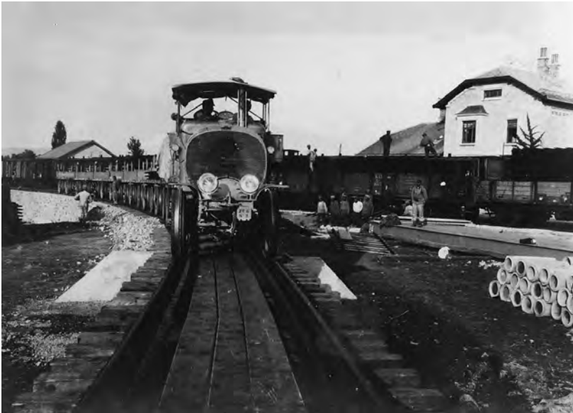
FOTO 17: GRADNJA ŽELEZNIŠKE INFRASTRUKTURE. VIR: PANG 583, ZBIRKA FOTOGRAFIJ, T. E. 23, A. E. 203, 1. ALBUM, ŠT. 83.
