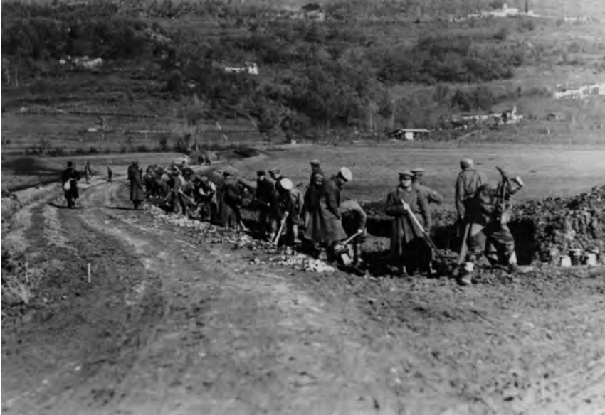
FOTO 14: GRADNJA CESTE IZ LOKEV PROTI RAVNICI. VIR: PANG 583, ZBIRKA FOTOGRAFIJ, T. E. 19, A. E. 157 B, ŠT. 26.
