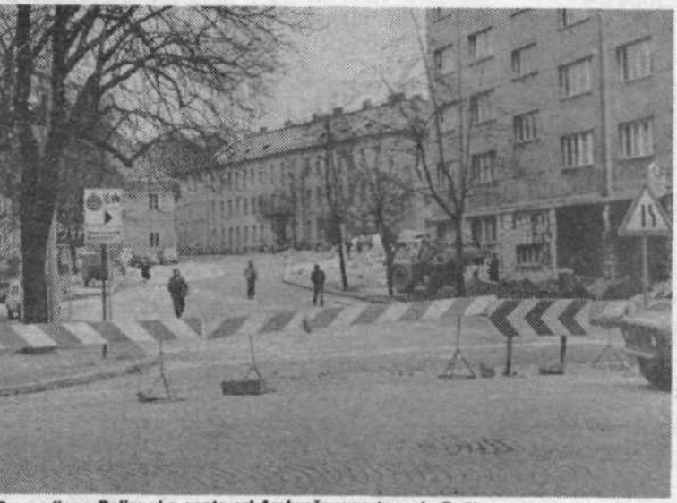
Prenovljeno Poljansko cesto od Ambroževega trga do Roške ceste so odprli 15. aprila.
