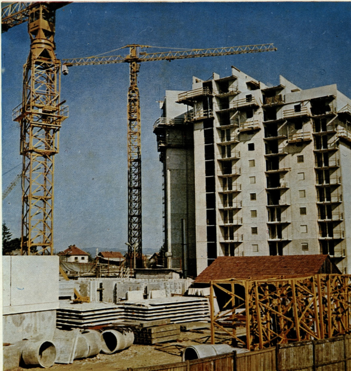
PZ GIPOSS (GP Obnova, GP Tehnika, SGP Pionir): Gradnja soseske SŠ-8/1 v Ljubljani po sistemu težke montaže
