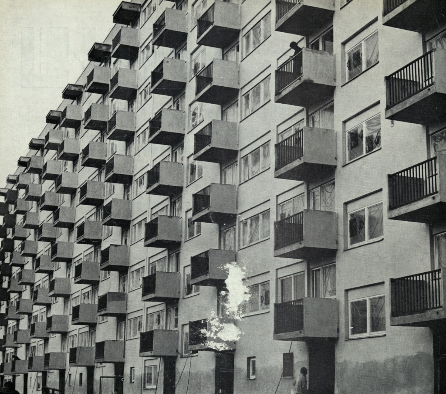
130 STANOVANJSKI BLOK »UTRINA« V ZAGREBU
