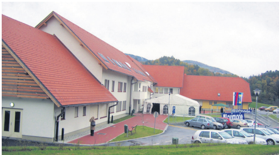
Kdo bo vodil ta zavod? Stavba novega Centra za usposabljanje, delo in varstvo Dobrna je bila odprta leta 2007.
