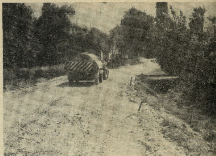
Pripravljalna dela za asfaltiranje ceste od Sentruperta do Dolenje vasi so končana. Še asfaltna plast in uresničena bo dolgoletna želja prebivalcev Kaple vasi.
