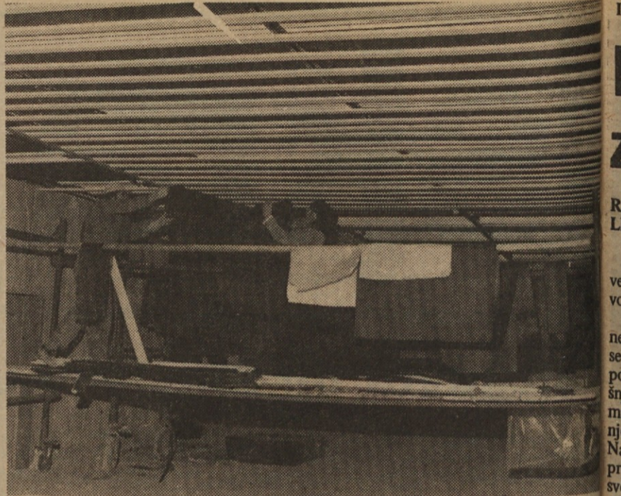
Montaža stropnih elementov v PPC.
