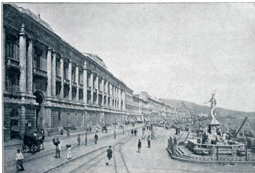
PALACE OB PRISTANIŠČU V MESINI, PORUŠENE OD POTRESA
