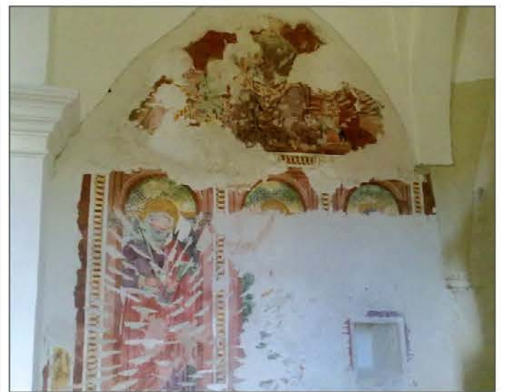
Particolare del restauro della chiesetta
