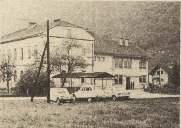
VNOVIČ PRELOŽENO – Blizu sto let stara vavtovski šola je med tremi izobraževalnimi ustanovami v novomeški občini, katere dograditev predlagajo iz leta v leto. Zaradi novih razmer pri gradnji negospodarskih objektov pa vse kaže, da bo gradnja spet ostala le zapisana v programu. (Foto: R. Bačer)
