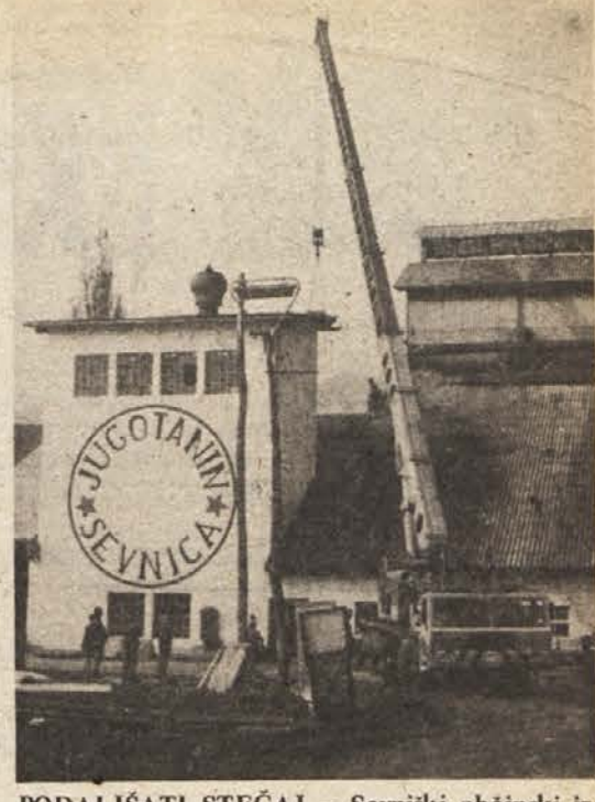
PODALJŠATI STEČAJ – Sevniški občinski izvršni svet je v ponedeljek poslušal poročilo o 18-mesečnem stečaju Jugotanina. Rok naj bi podaljšali do kraja leta. Tovarna je trenutno v remontu. Na sliki: nameščanje transportnega traku za lesne sekance namesto neuspelega pnevmatskega. (Foto: A. Železnik)
