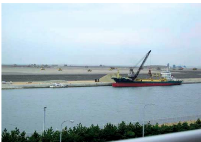
Slika 3 • Gradnja druge faze letališča Kinsai (Osaka) na umetnem otoku leta 2006
