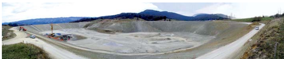
Slika 20 • Panorama bazena med gradnjo jeseni 2007; veliki nasip levo in mali nasip desno zgoraj
