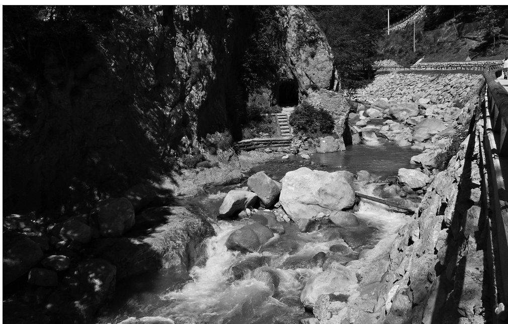
Slika 8: »Obzidana« struga Tržiške Bistrice po sanaciji struge po ujmi oktobra 2018 (foto: Matija Zorn, september 2020).
